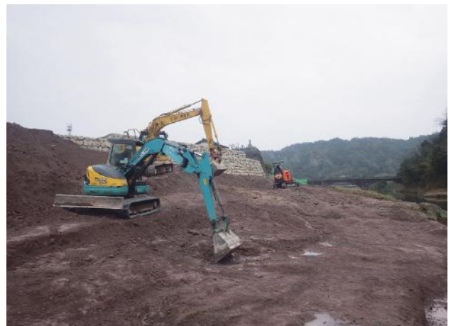
写真 5-1-19 小型重機による掘削
