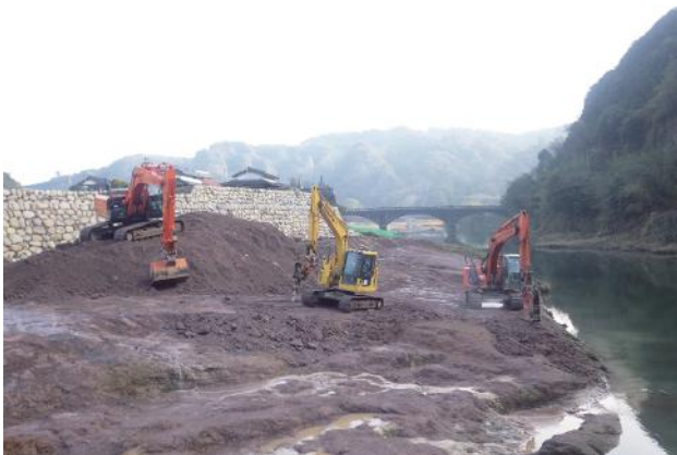
写真 5-1-18 小型重機による掘削
