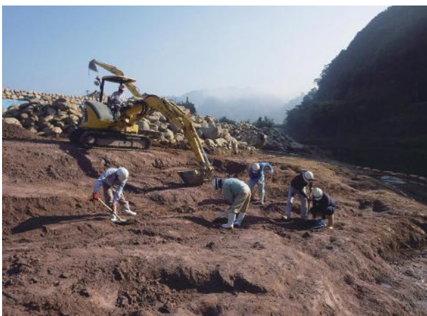
写真 5-1-20 人力による仕上げ掘削
