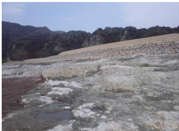
写真 5-1-22 岩掘削完了
