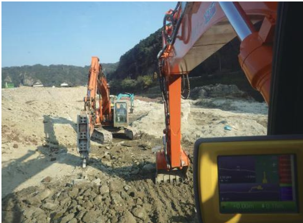
写真 5-1-16 完成模型データをインプットした重機
