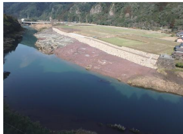
写真 5-1-4 上曾木地区 完成
