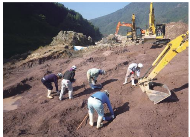
写真 5-1-21 人力による仕上げ掘削
